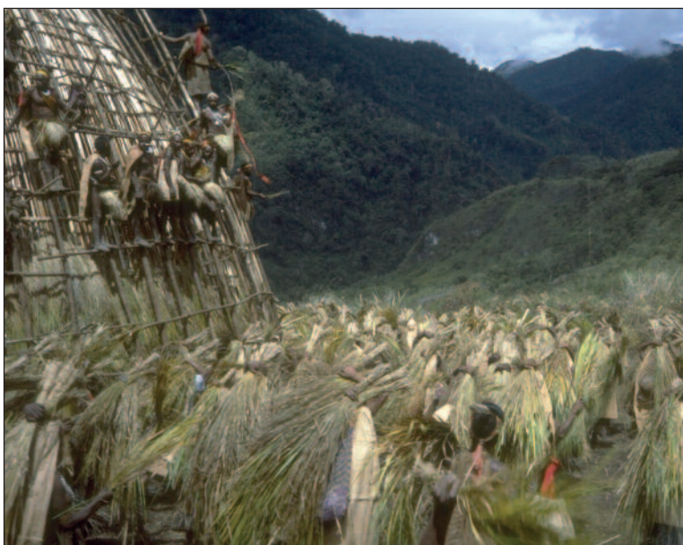
Le squelette de la Tsimia est construit et les femmes de la tribu apportent chacune une gerbe de chaume pour couvrir le toit de l'édifice. Les Baruya appellent cela "faire la peau" de la maison des initiations dont les hommes ont fabriqué la squelette. Il faut remarquer que les hommes sont montés sur le toit pour éviter tout contact avec la foule des femmes considérées comme menaçant la force et la virilité des hommes. Cliché de Pierre Lemonnier.
